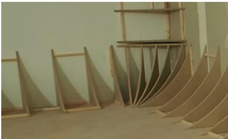
Luego se cubrirá toda la superficie curva con madera MDF 3mm o placas de yeso, según mejor criterio constructivo a acordar entre el contratista y la Inspección.
